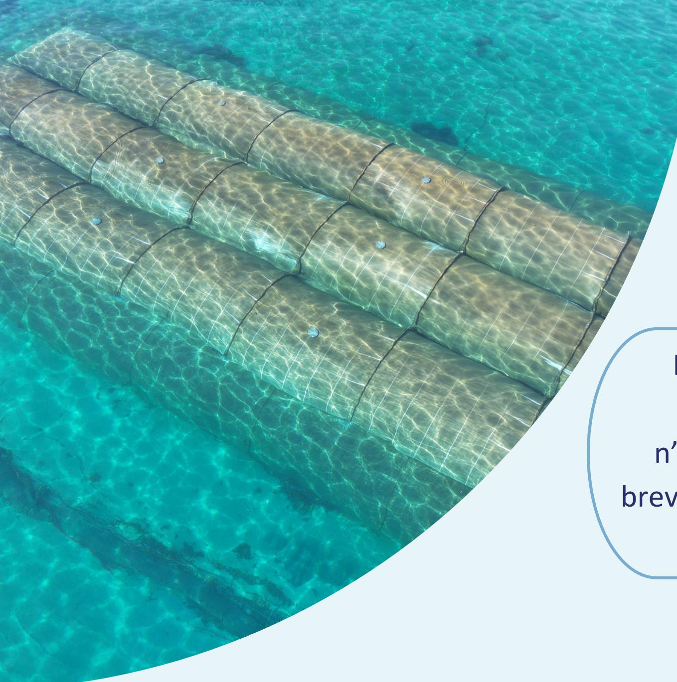
Les GeoWave sont utilisés sur les **zones côtières** soumises à l'**érosion**. Ils permettent de **dissiper la houle** avant qu'elle n'atteigne la côte et érode le littoral. Nous avons développé et breveté un **géotextile** tramé de fils de cuivre permettant de réaliser du **Geocorail** sur des structures souples.
